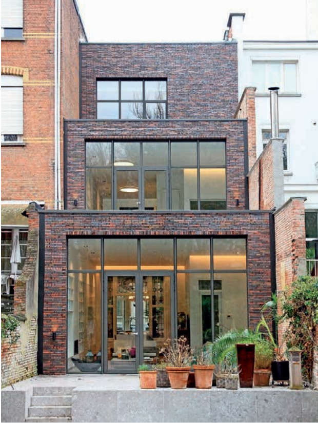
De bestaande achterbouw van dit burgerhuis in de Jan Van Rijswijcklaan in Antwerpen werd gesloopt en vervangen door een nieuwbouwwolume parallel aan de bestaande achtergevel. Het resultaat vormt een samenhangend geheel, zowel qua materialisatie als vormgeving, en voorziet in een meer geoptimaliseerd ruimtegebruik van de perceelbreedte en in een betere aansluiting op de bureaus
